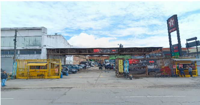
Fachada del Inmueble
