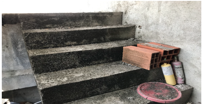
Escalera común - CJ
