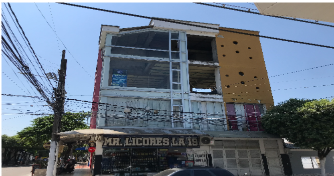
Fachada del Inmueble
