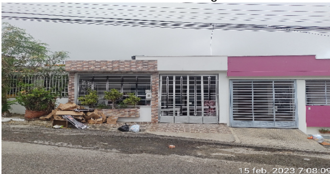
Contador de Energia
