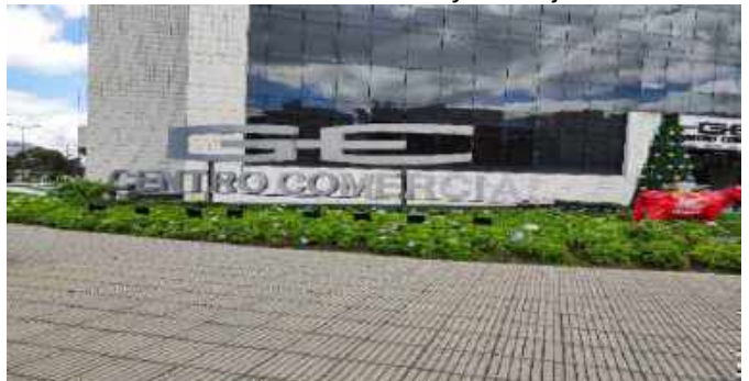
Nomenclatura Inmueble y/o Conjunto
