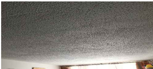
Detalle de acabados
