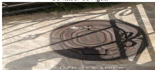
Contador de Agua
