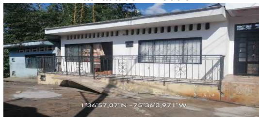
Fachada del Inmueble
