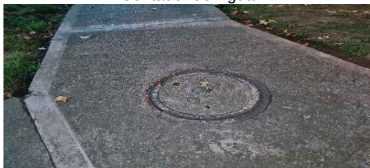
Contador de Agua
