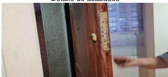
Detalle de acabados
