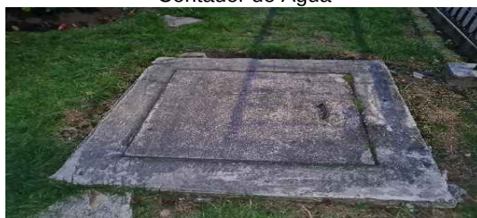
Contador de Agua
