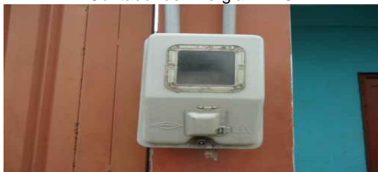
Contador de Energia APTO
