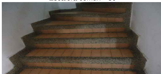
Escalera común - CJ
