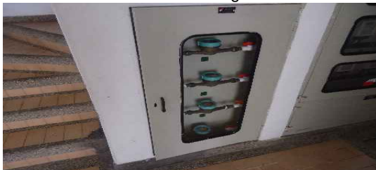
Contador de Agua
