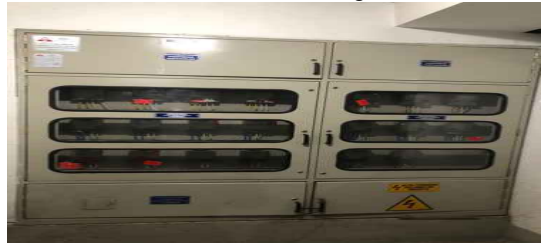
Contador de Energia
