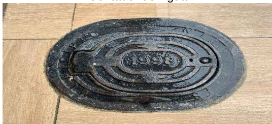
Contador de Agua
