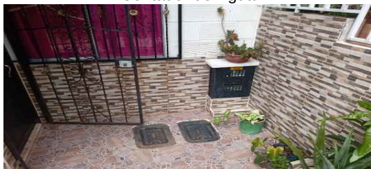
Contador de Agua
