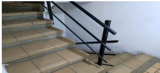
Escalera común - CJ
