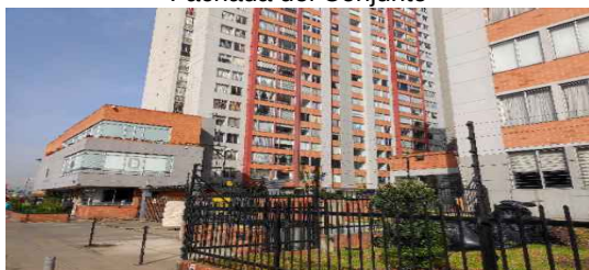
Fachada del Conjunto
