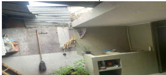
Zona de Ropas
