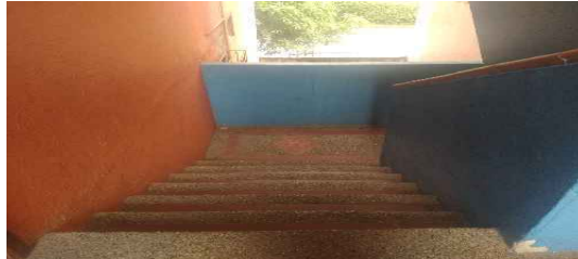
Escalera común - CJ
