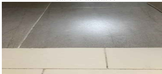
Detalle de acabados
