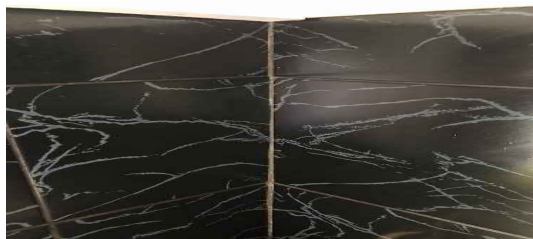
Detalle de acabados
