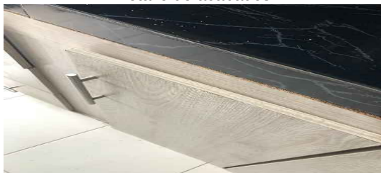
Detalle de acabados
