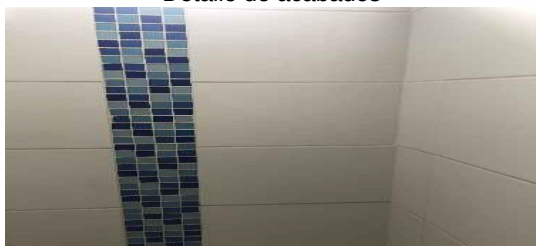
Detalle de acabados
