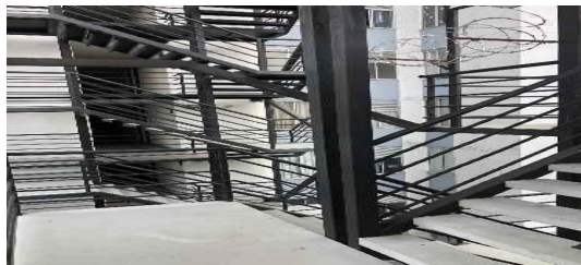
Escalera común - CJ
