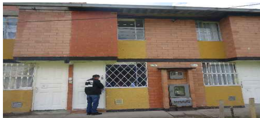
Fachada del Inmueble
