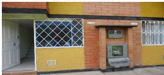
Fachada del Inmueble
