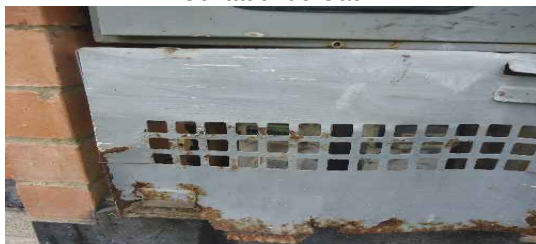
Contador de Gas
