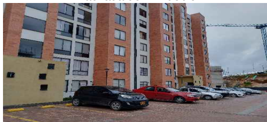
Fachada del Inmueble
