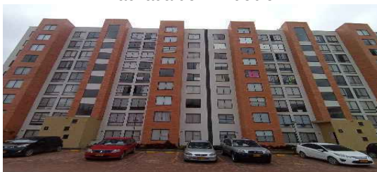
Fachada del Inmueble
